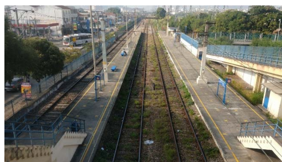
Figura 5-10 – Estação Rocha Miranda – 10/07/2021
