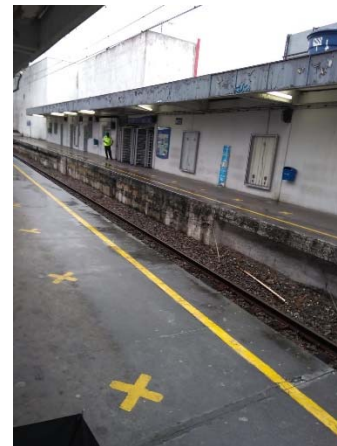
Figura 5-27 – Estação Campo Grande – 28/07/2021
