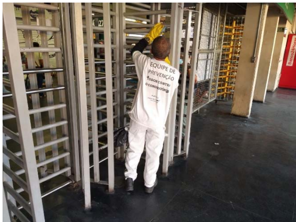
Figura 5-1 – Estação Nova Iguaçu – 01/07/2021
